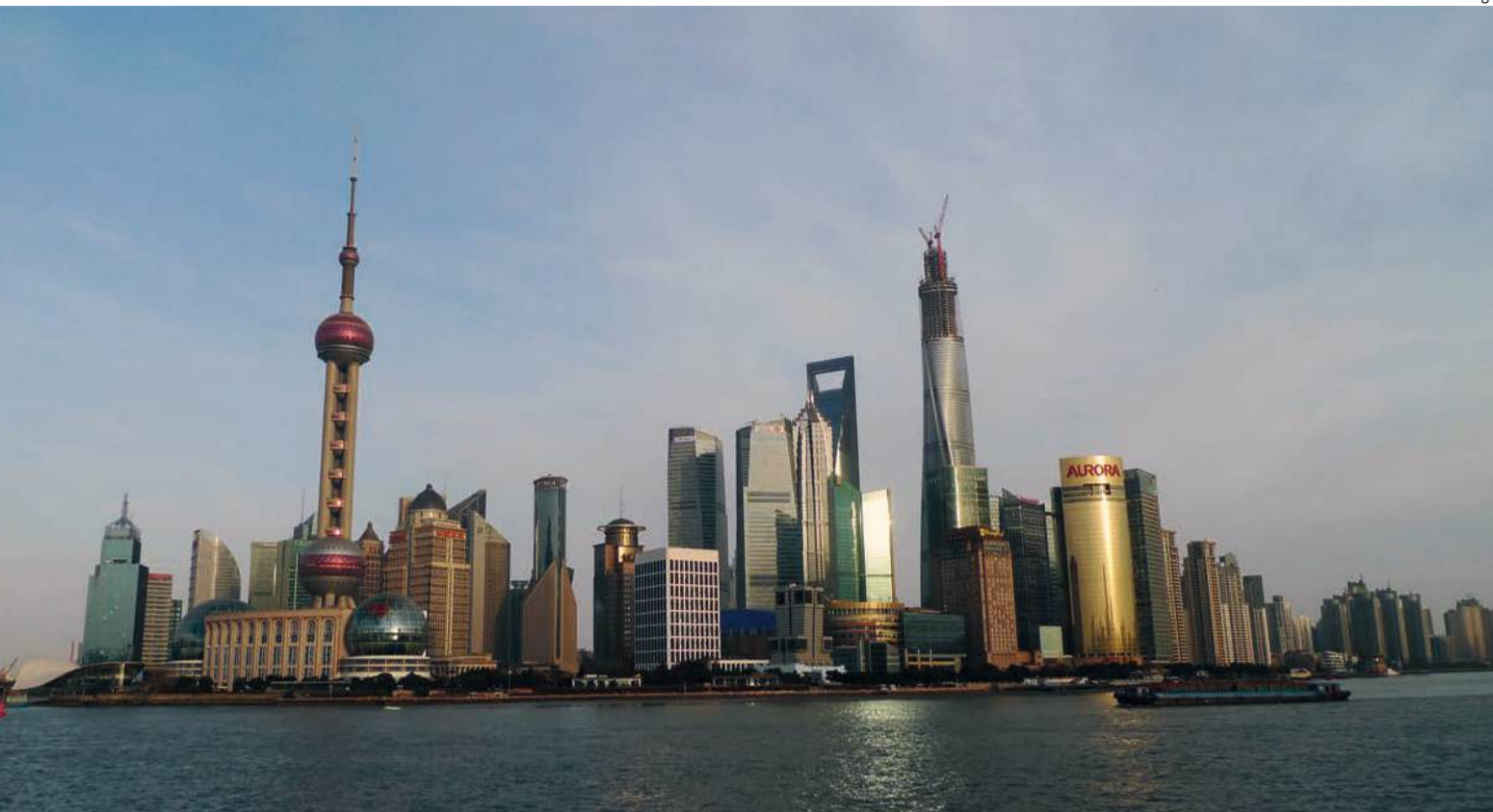
Centro financeiro e comercial no distrito de Pudong, em Xangai, visto a partir do bairro de Bund: China se beneficiou da hegemonia do neoliberalismo
